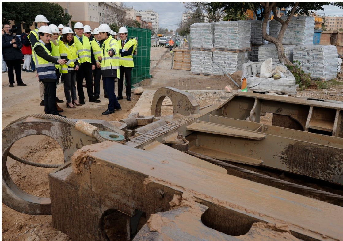
Visita a la obra de ampliación del metro de Sevilla Manuel gómez
